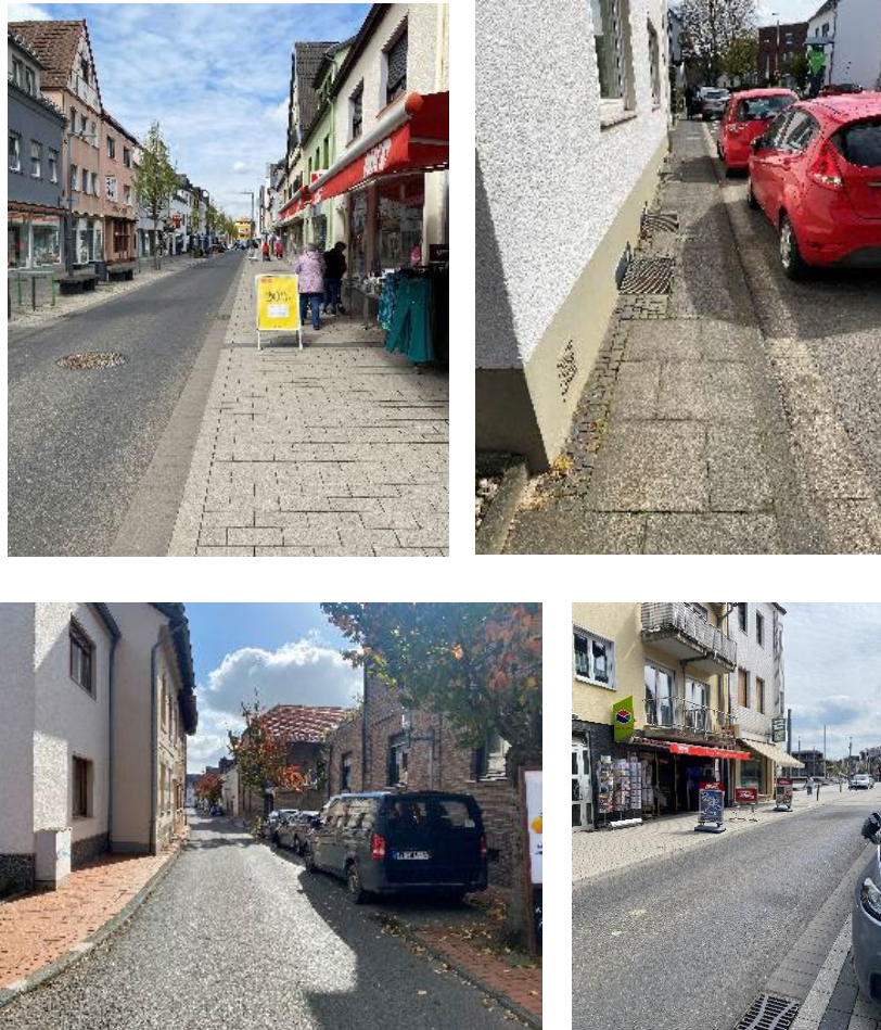
Abbildung 4-14: Breite einschränkende Barrieren auf dem Gehweg: Professor-Scheeben-Str. und Hauptstraße 38
