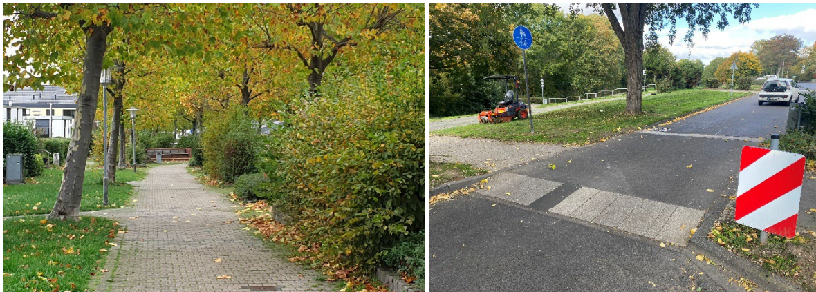
Abbildung 4-10: Attraktive Nahmobilitätsachsen in Meckenheim; Aufpflasterung (l.), Niveaugleiche Querung für Fuß- und Radverkehr an Promenade (r) 30
