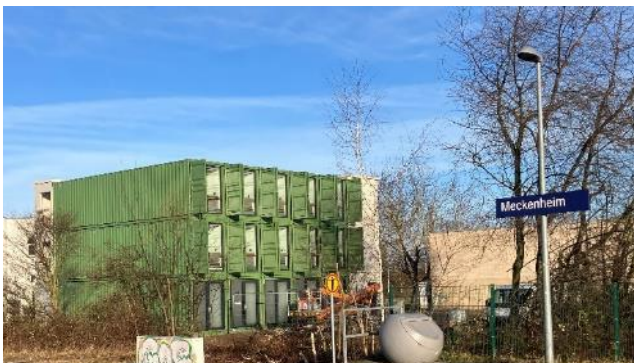
Die Seecontainer für das Hotel Tin Inn wurden Anfang Februar aufgestellt.
