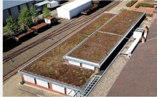
Dachbegrünung von Hallen im Gewerbegebiet (Foto: K.PLAN)
