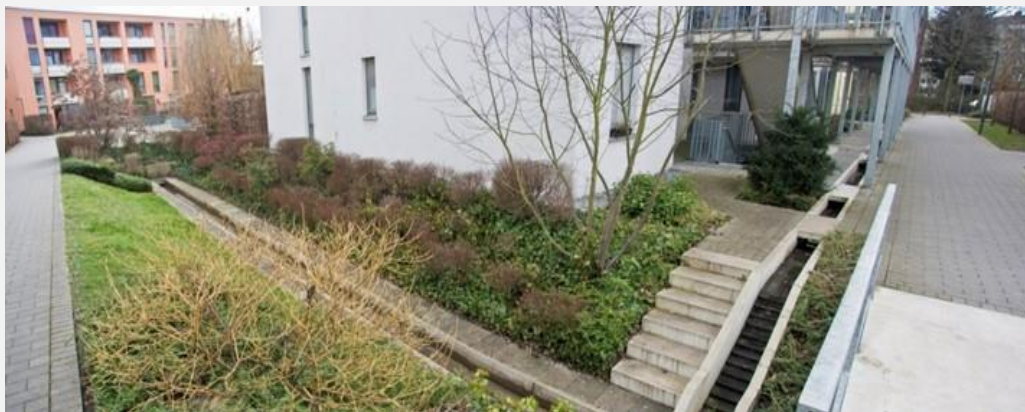
Beispiel: Wasserspielplatz mit Zwischenspeicherung (Neuss, Foto: K.PLAN)
