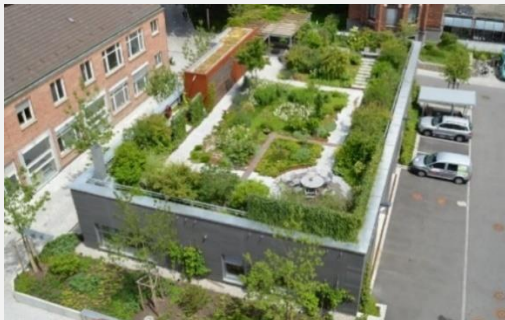
Intensive Dachbegrünung mit Gartennutzung
