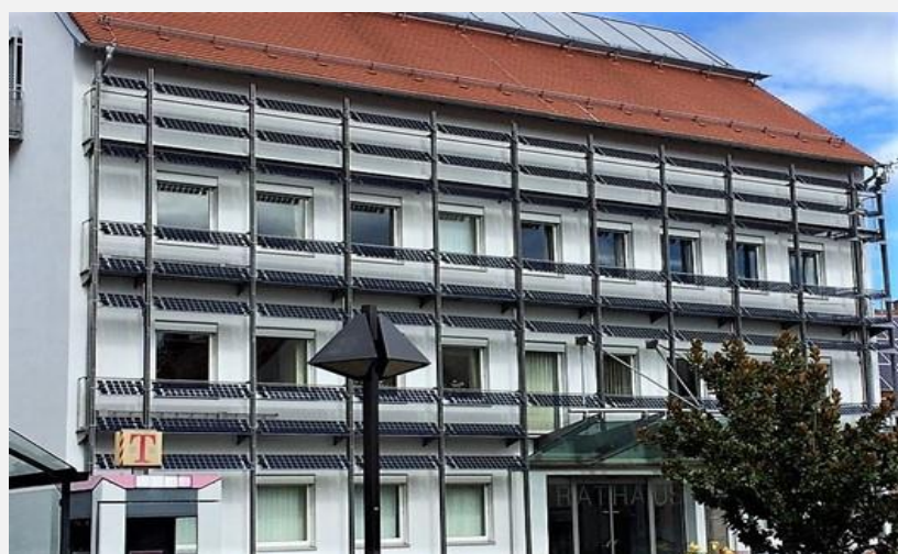
Verschattung durch PV-Anlagen (Foto: Stadt Wuppertal)
