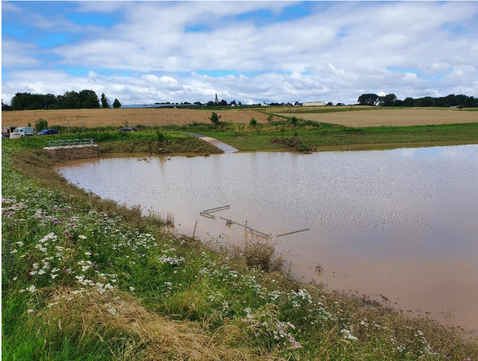
Hochwasserrückhaltebecken Nierendorf, Grafschaft (Leimersdorfer Bach) 15.07.2021, 11:22 Uhr MESZ
