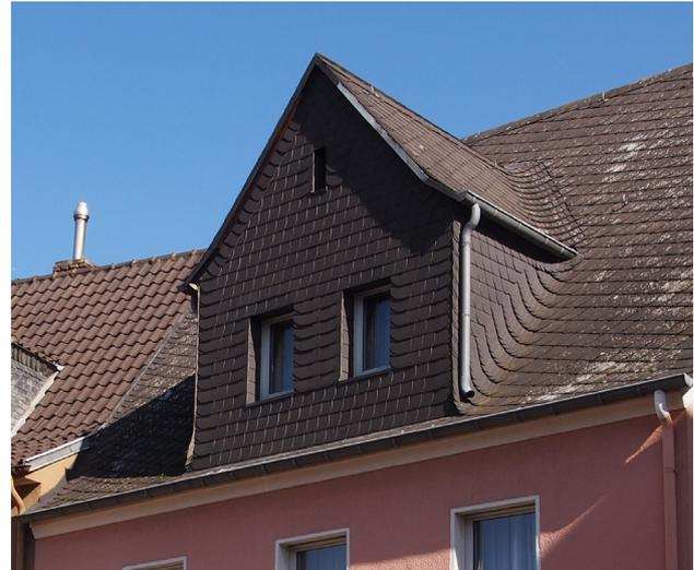
**Bild 92:** Die Giebelgaube mit Schindelfassade aus den 1950er Jahren nimmt ca. 50 Prozent der Gebäudebreite ein.
