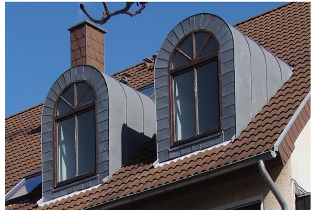
**Bild 93:** Moderne Giebelgauben mit Tonnendach und Zinkverkleidung.
