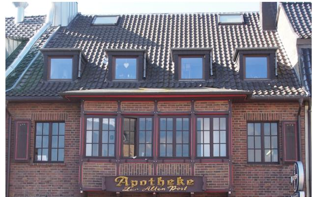
Bild 89: Die Dachgauben entwickeln sich aus dem Fassadenraster
